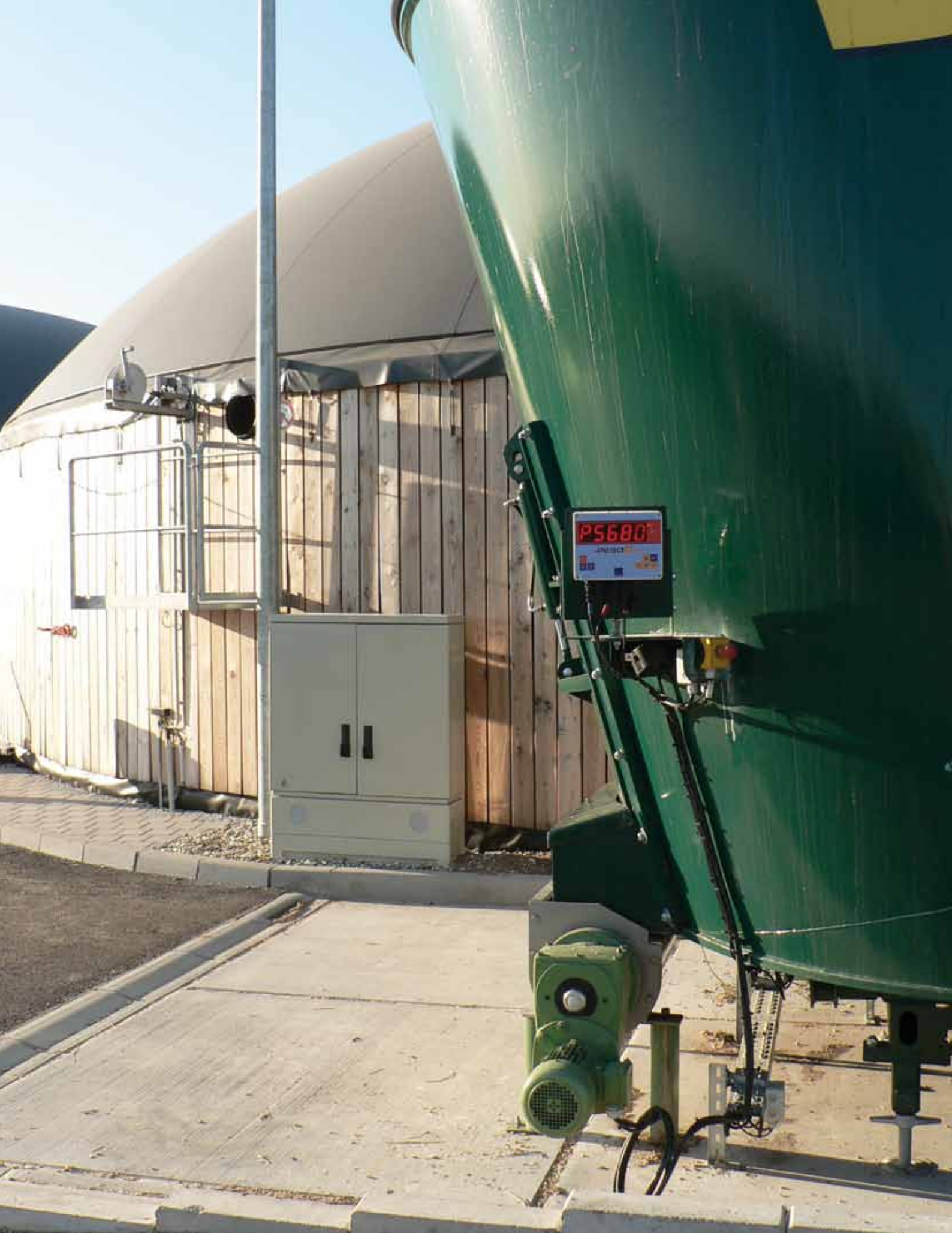
Biogasanlage mit Fermenter und automatischer Substratzuführung.
