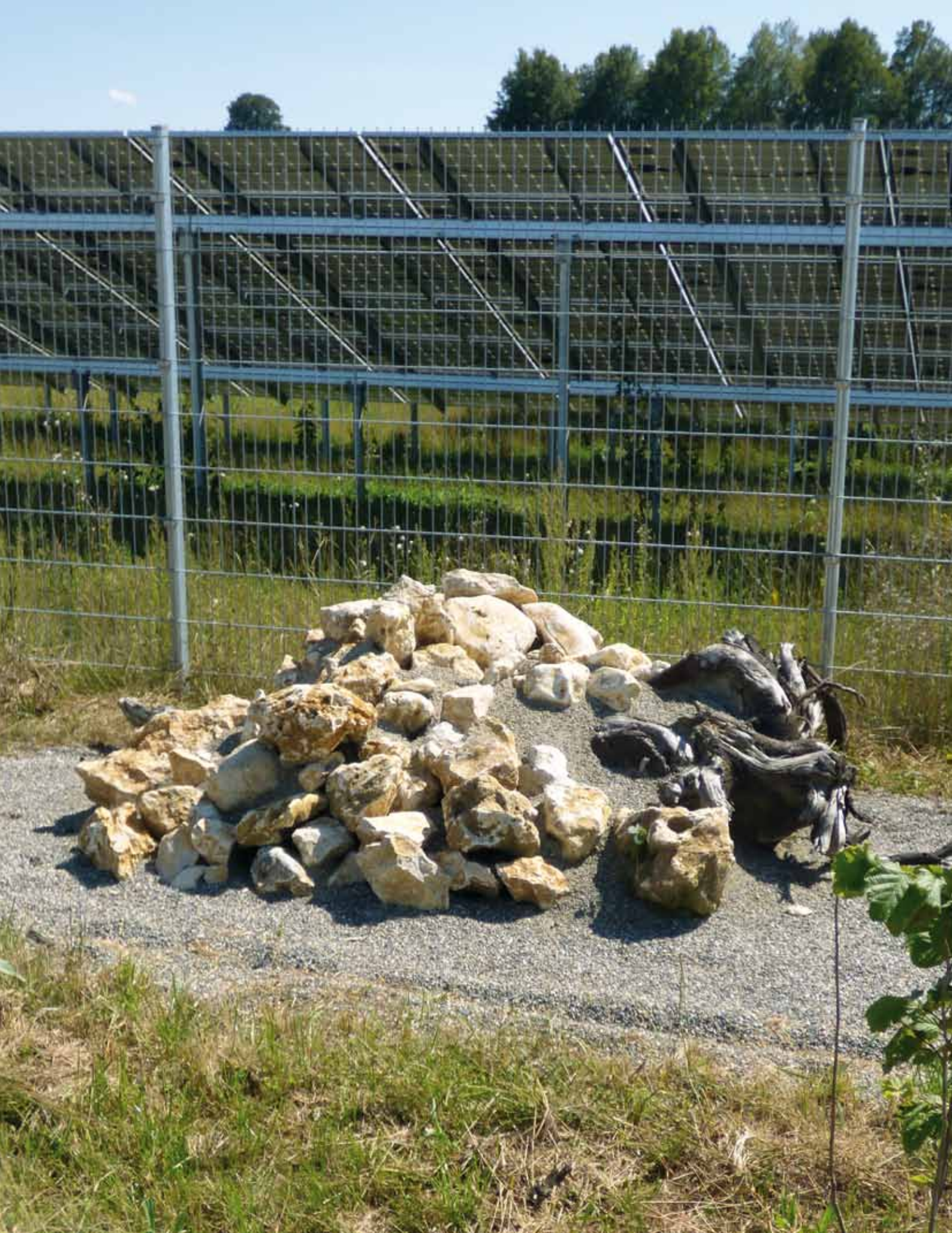
Freiland-Photovoltaikanlage mit gestaltetem Lebensraum für Eidechsen bei Berghülen.
