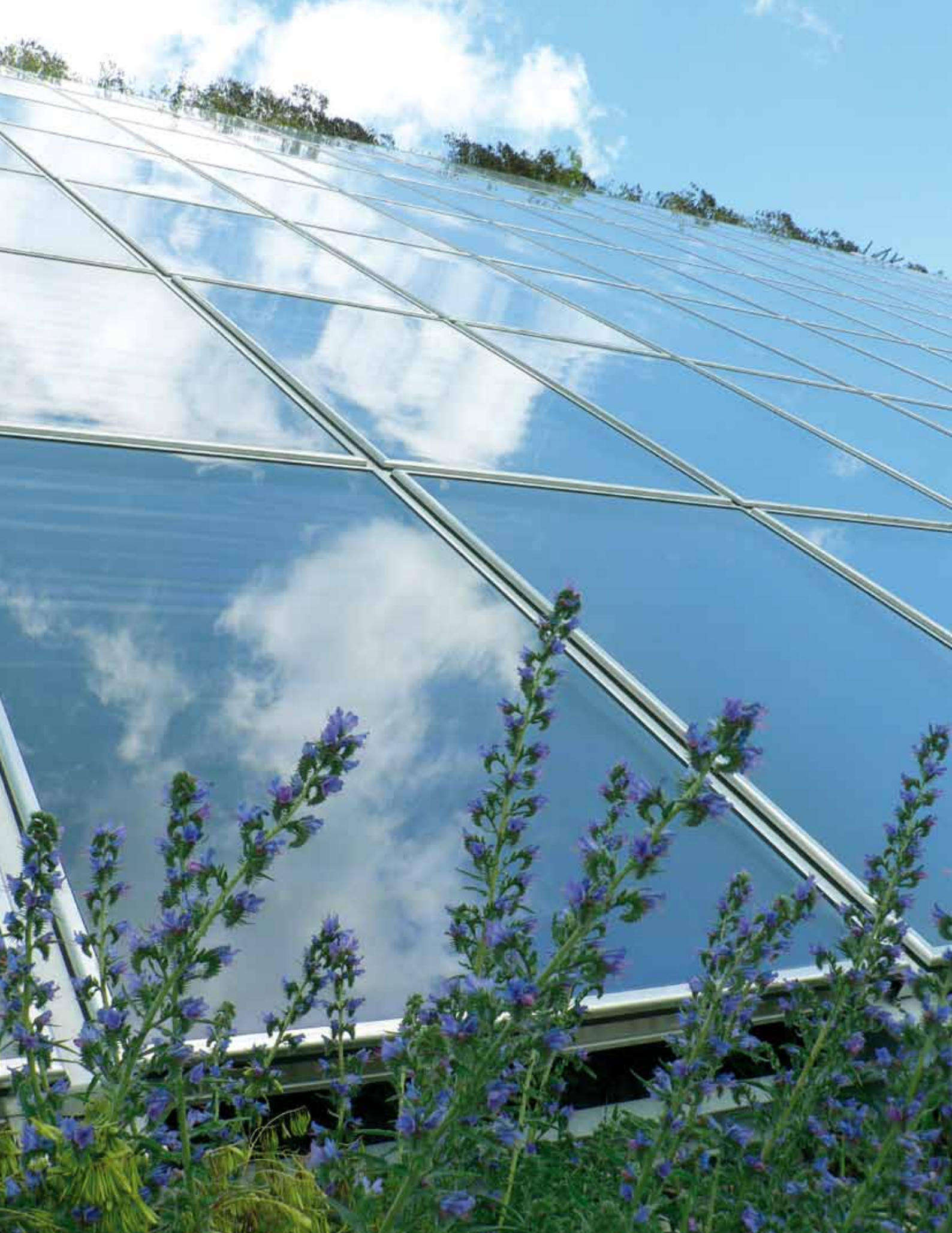
Solarthermischer Großkollektor mit Freilandaufstellung.
