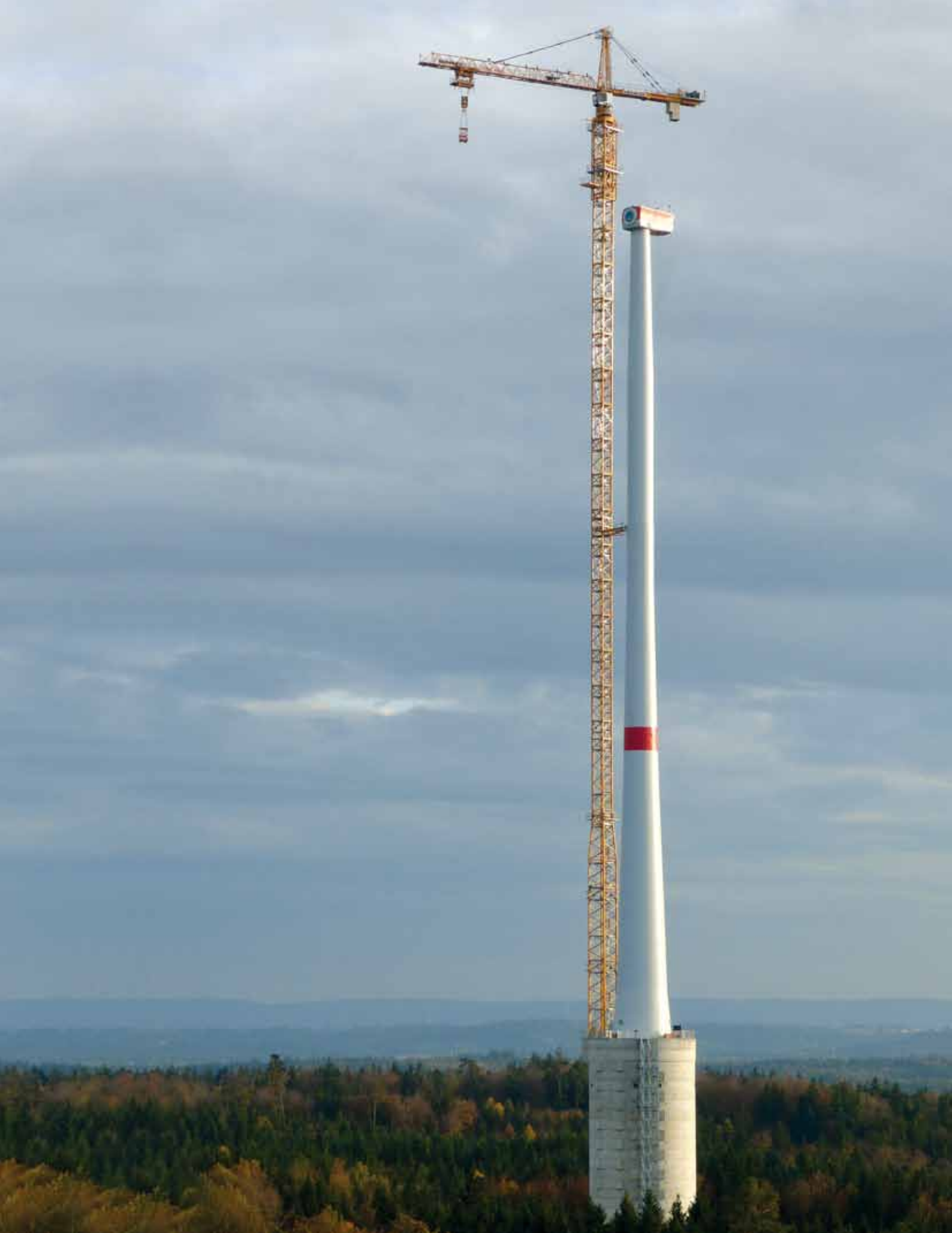
Aufbau einer Windenergieanlage mit Speicherfunktion bei Gaildorf.
