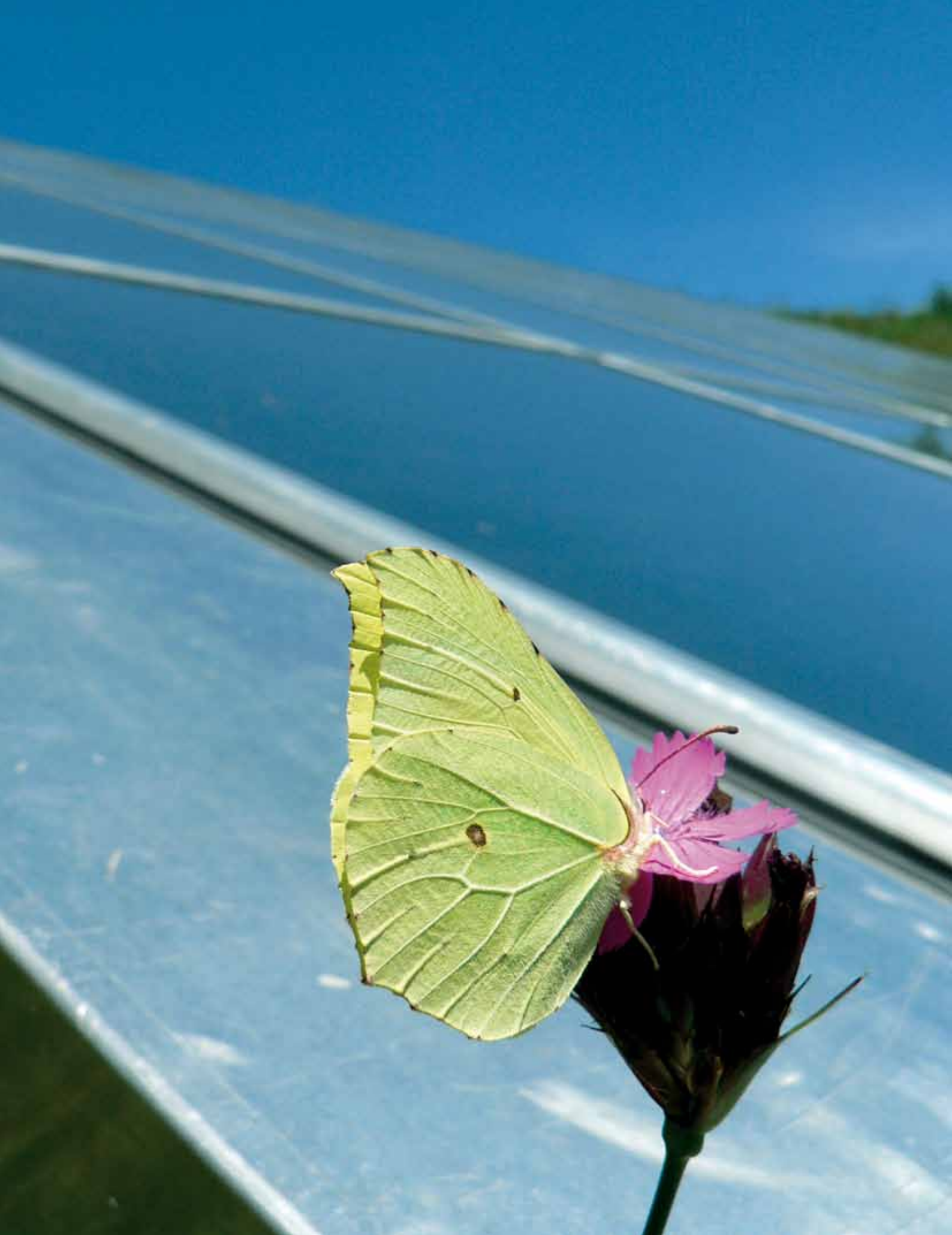
Großes Kollektorfeld für solarthermische Anlage in Crailsheim.
