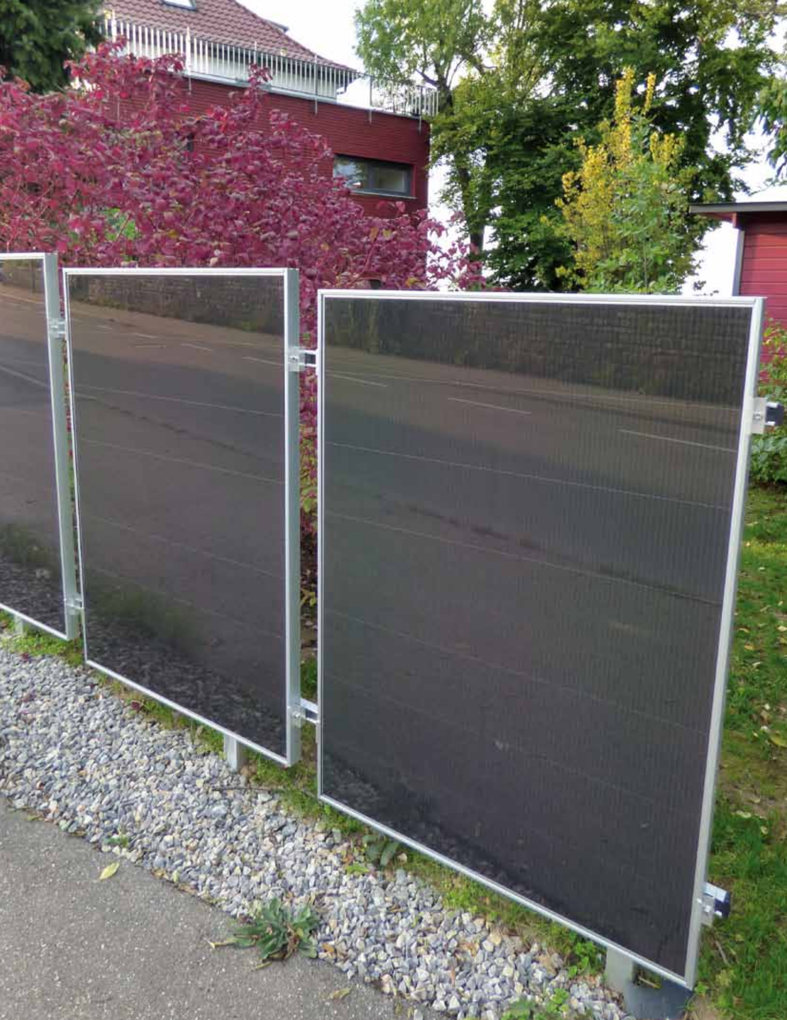
Photovoltaik-Module mit Doppelfunktion als Zaun.
