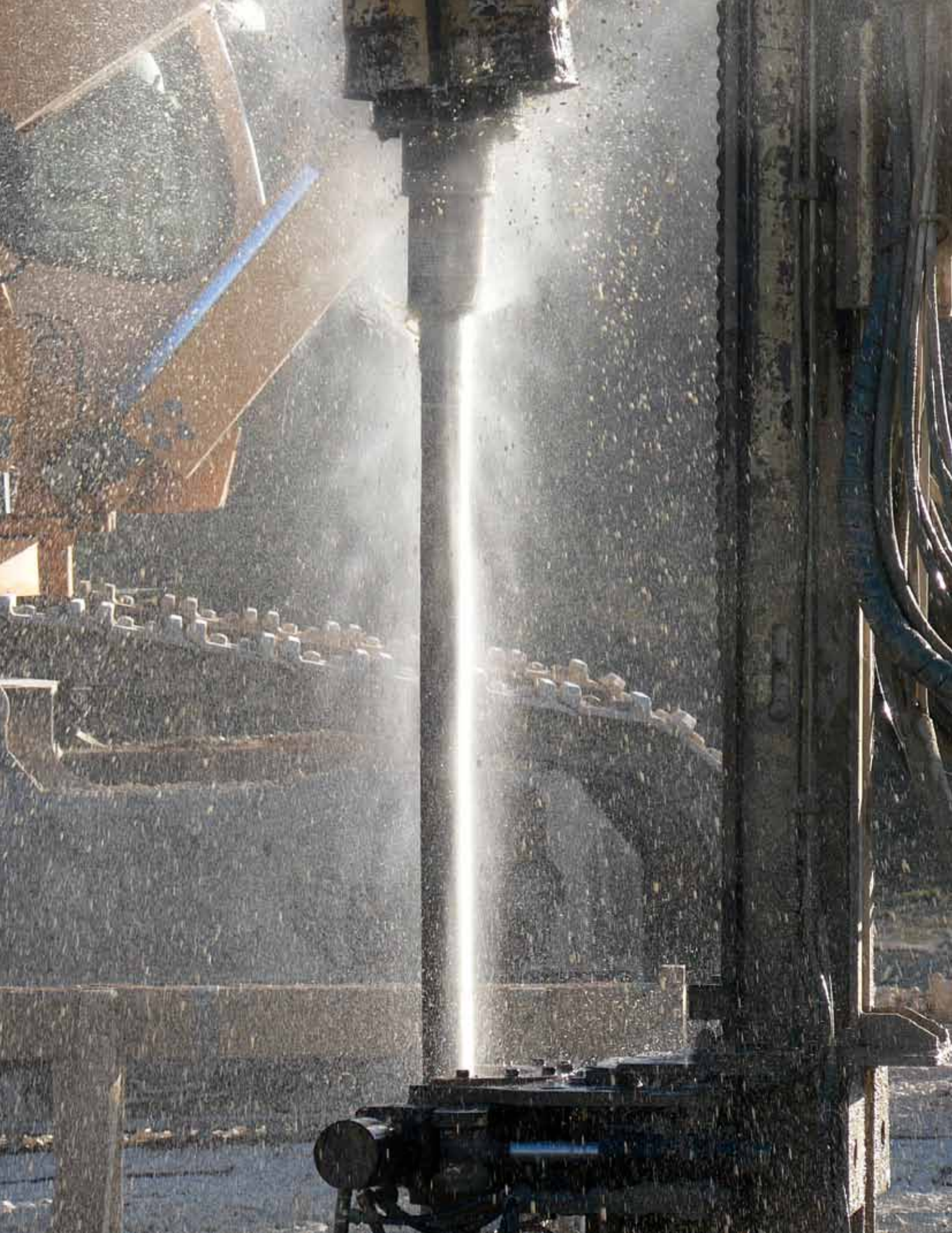
Bohrung für oberflächennahe Geothermie.
