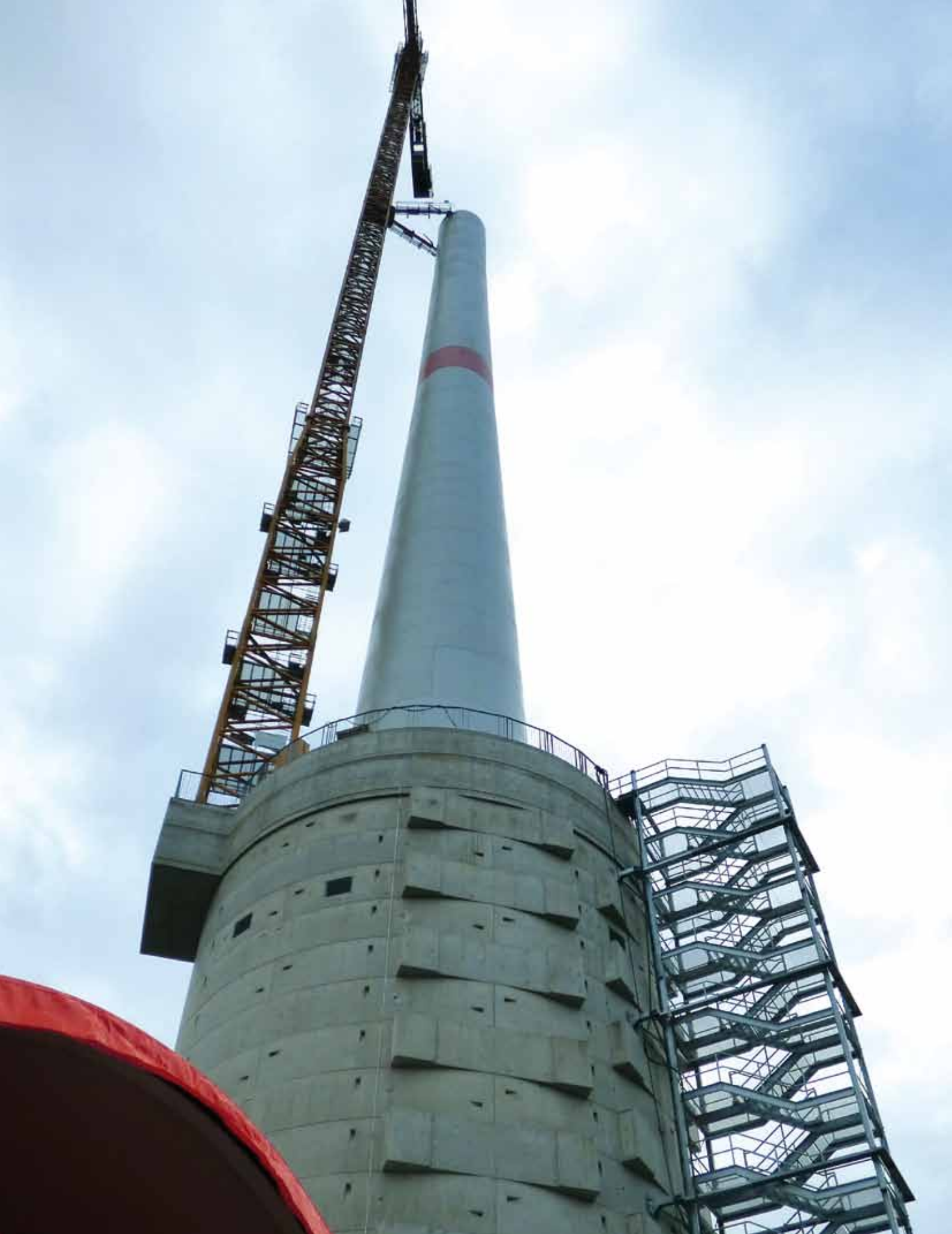
Windkraftanlage mit integriertem Wasserspeicher bei Gaildorf.
